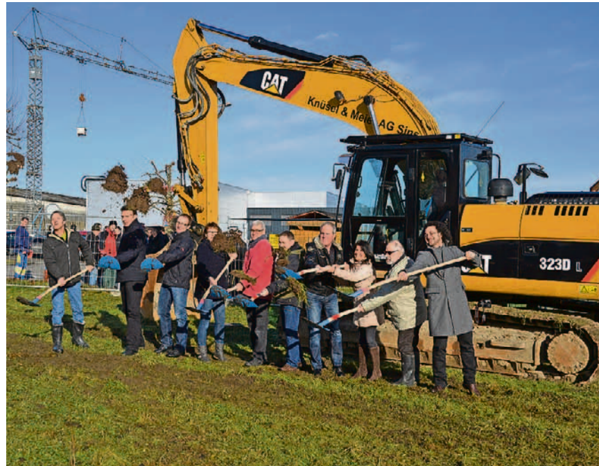
Die Baukommission mit dem Präsidenten der Ortsbürgerkommission Auw, Hans Burkard (links), beim Spatenstich für die neue Wohnüberbauung Tribetfeld.
