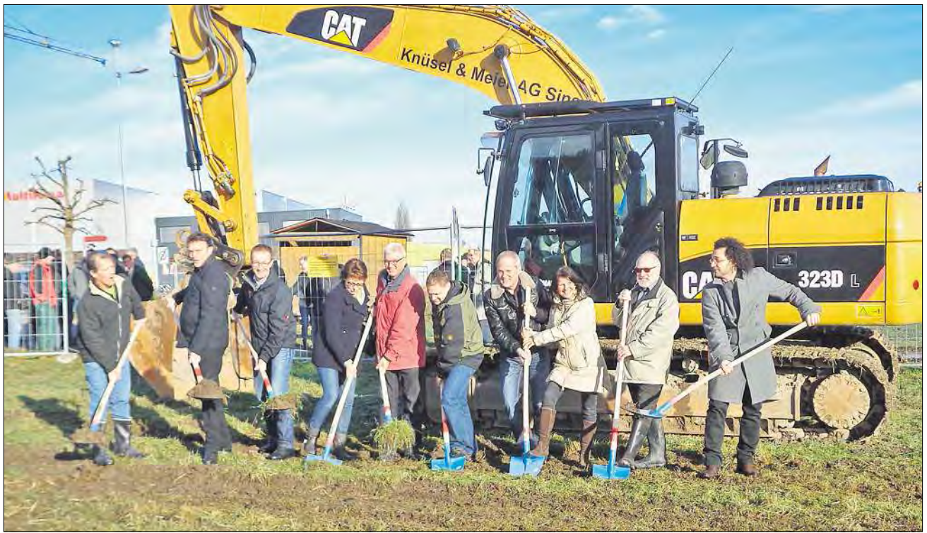
Die Mitglieder der Baukommission nehmen den Spatenstich vor Bild: pe
