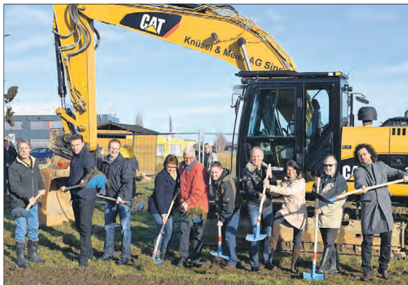
Grossaufmarsch für ein Grossprojekt: Der Spatenstich wird mit vereinten Kräften begangen.
